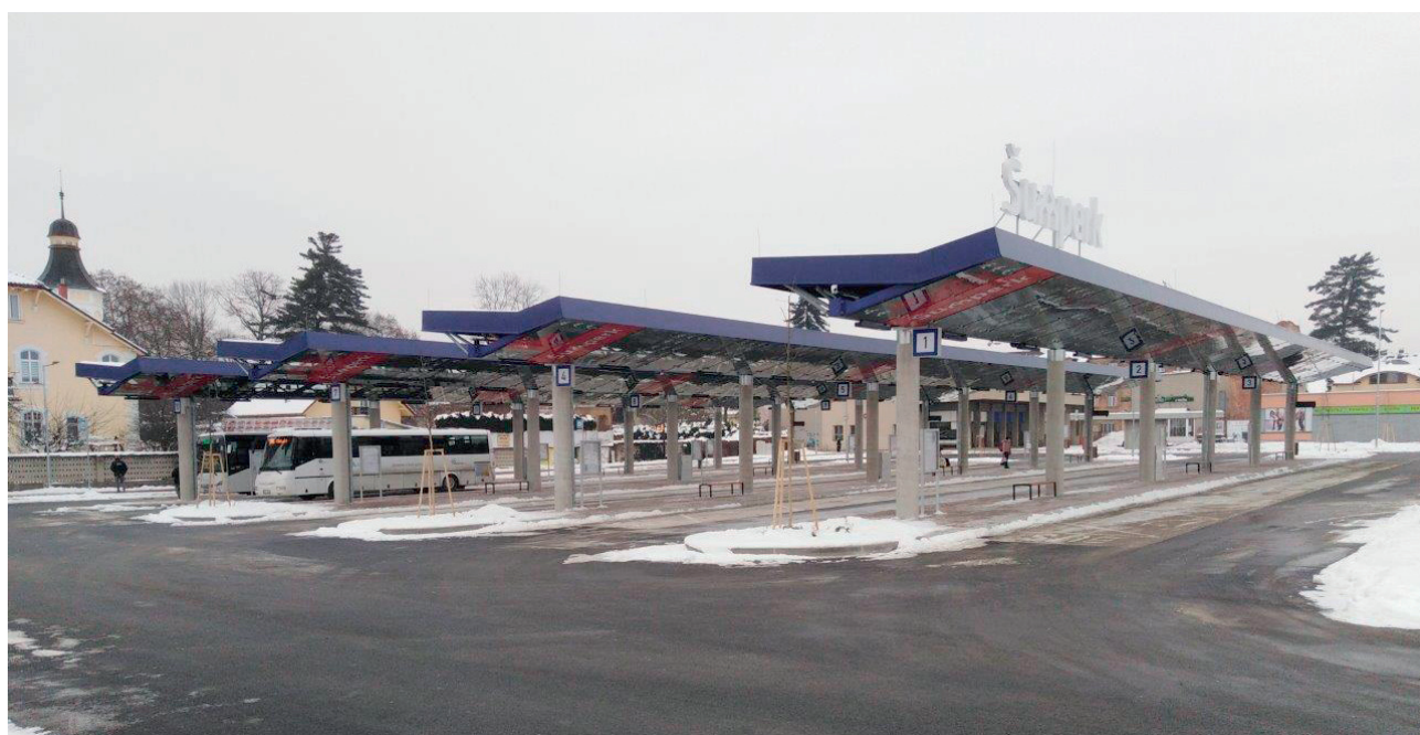
Obrázek 2 – Autobusové stanoviště v Šumperku po kompletní rekonstrukci
